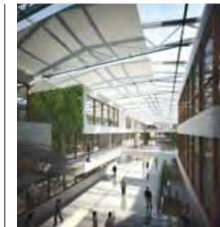
▲ Un atrium central lumineux, moteur d'une circulation d'air naturelle, évite la mise en place d'une climatisation.
